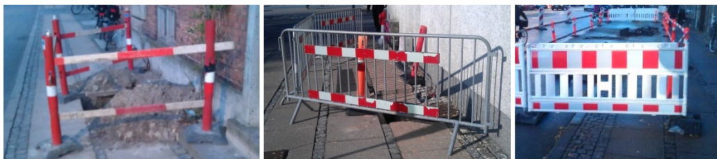
Figur 3.10. Eksempler på tværafspærring på fortov
