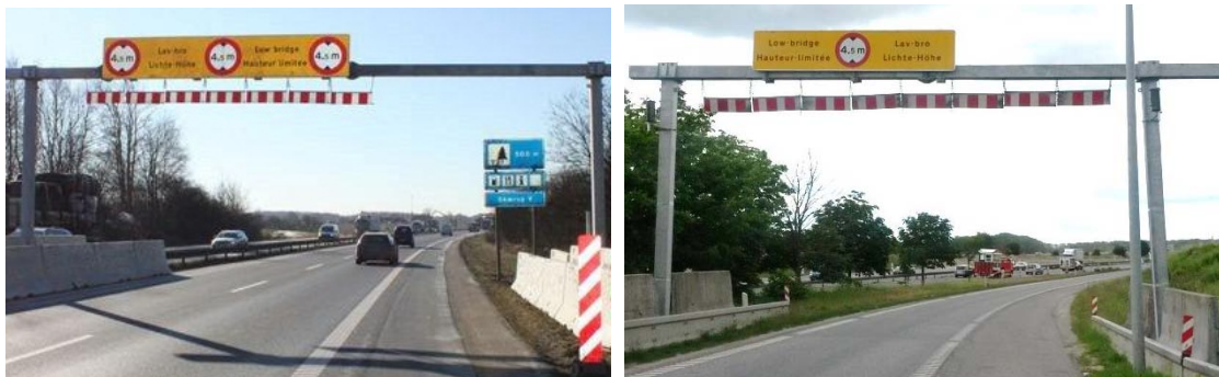
Figur 6.53. Eksempler på højdevarslingsportaler med metalplader (rasleplader)
