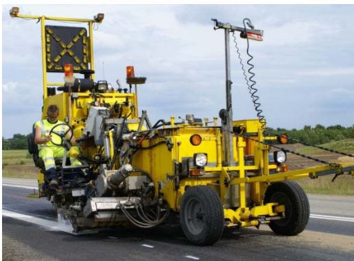
Figur 4.2 Eksempel på afstribning af kantlinje
