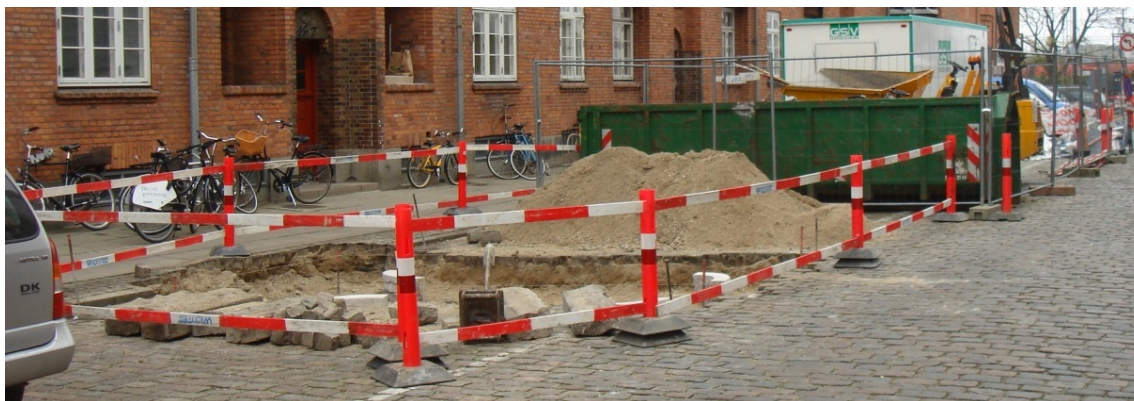
Figur 7.10. Eksempel på stationært vejarbejde på lokalvej i byområde med beskyttelsesniveau 2. Kant- og baggrundsafmærkning.
