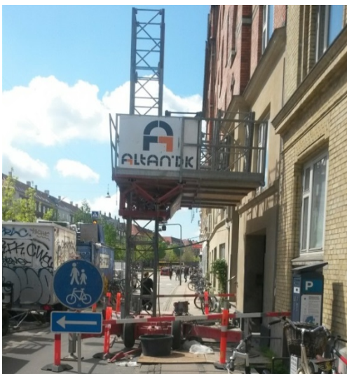
Figur 4.8 Eksempel på ikke-indregistreret arbejdsplatform i arbejdsområde på vejareal
