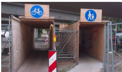
Figur 3.26. Eksempel på interimssti ved vejarbejde
