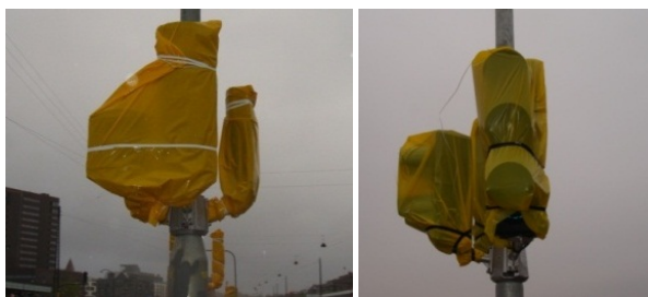
Figur 3.23. Eksempler på tildækning af lyssignaler med gule sække.
