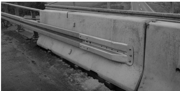
Figur 6.44. Eksempel på overgang mellem trafikværn og autoværn!
