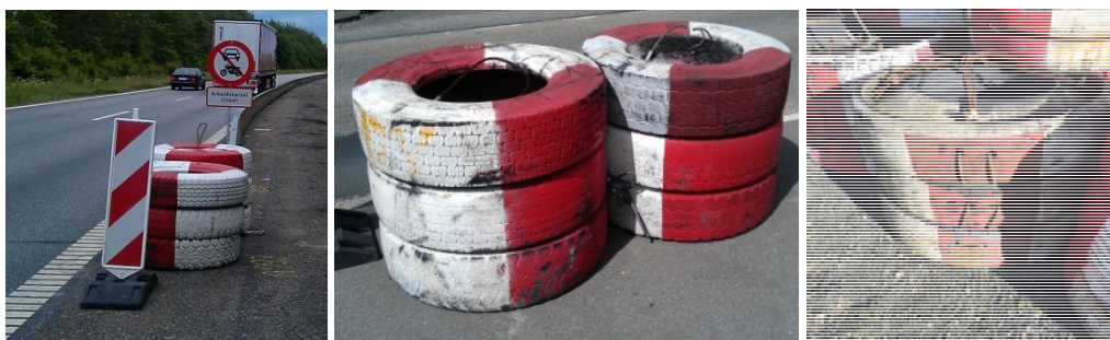
Figur 6.50. Eksempler på dæksøjler som er forsvarligt sammenkoblede.
