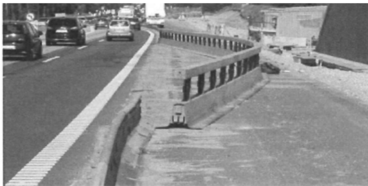
Figur 6.45. Eksempel på påkørt trafikværn med manglende forankring, overlap eller overgangsstykker
