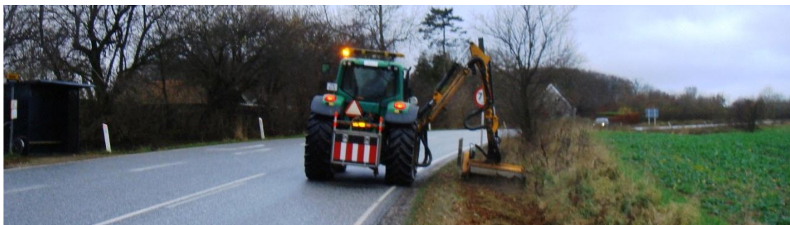
Figur 4.1. Eksempel på kørende vejarbejde i åbent land med beskyttelsesniveau 5. Maskinelt vejarbejde.
