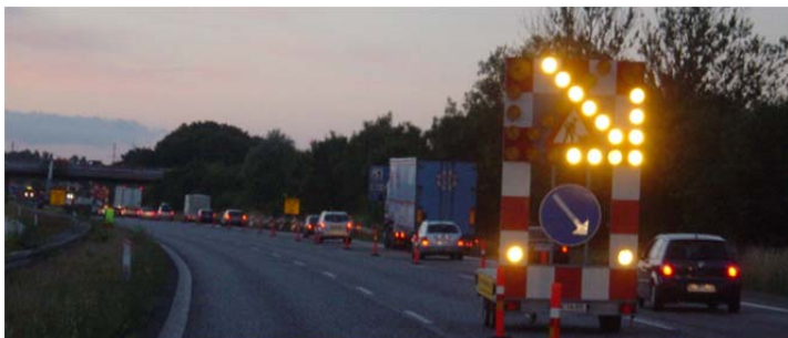
Figur 6.33. Eksempel afspærringsvogn med tændt lyspil og bundblink
