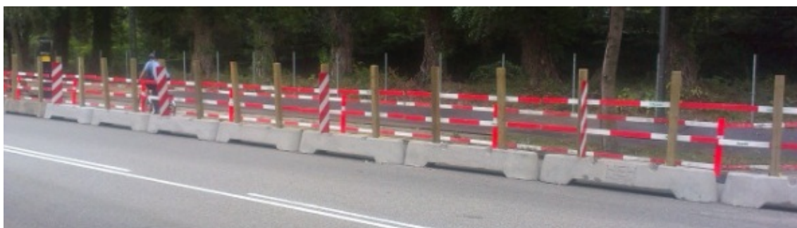
Figur 6.75. Eksempel på længdeafspærring med betonklodser mellem kørebane og cykelsti
